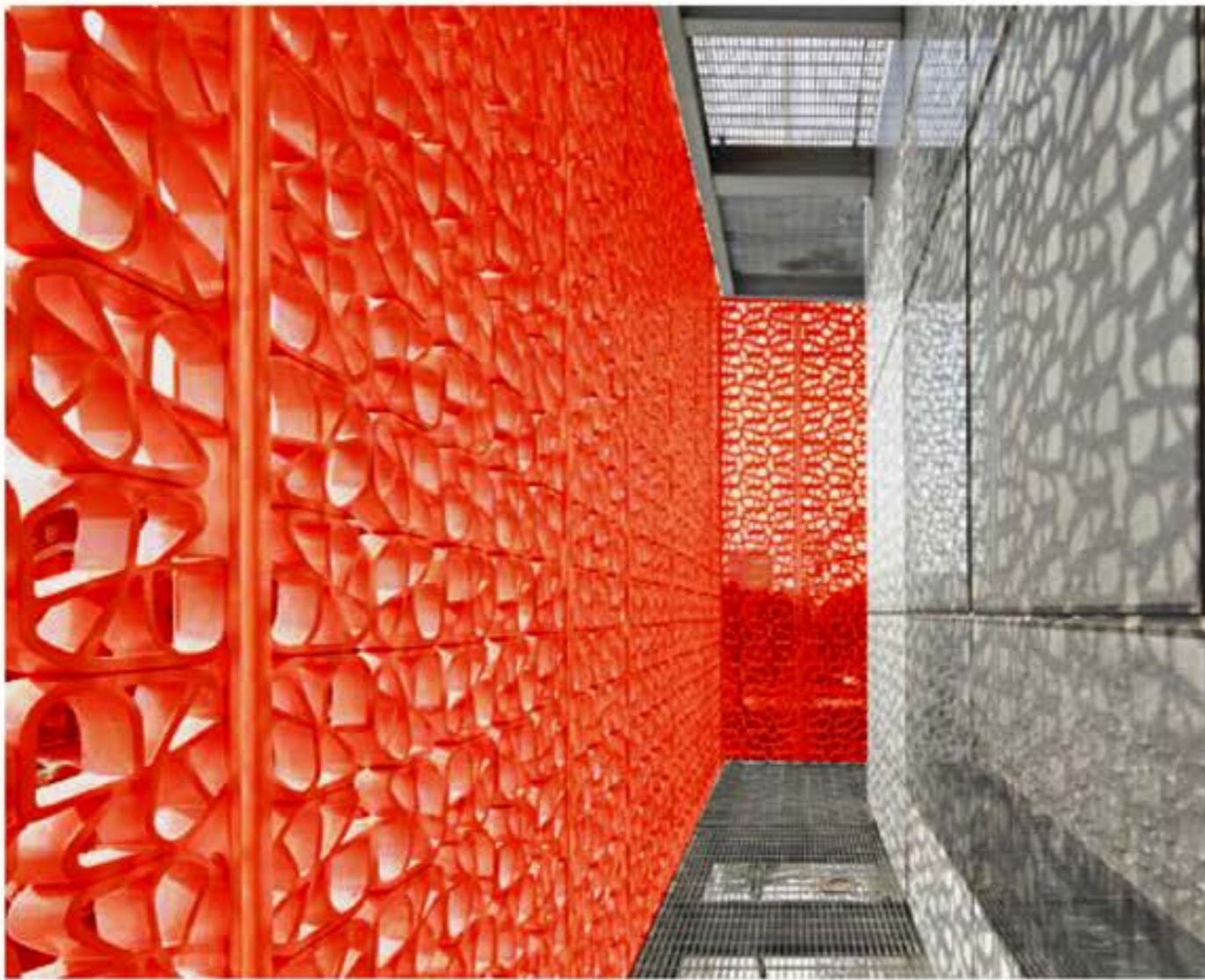
LA CORONA DI CORALLO Le facciate del Padiglione S, nella parte superiore, sono costituite da una nuova "pelle" con funzione schermante e struttura realizzata con elementi in lamiera metallica tagliati a laser e blocchetti in cotto smaltato.
