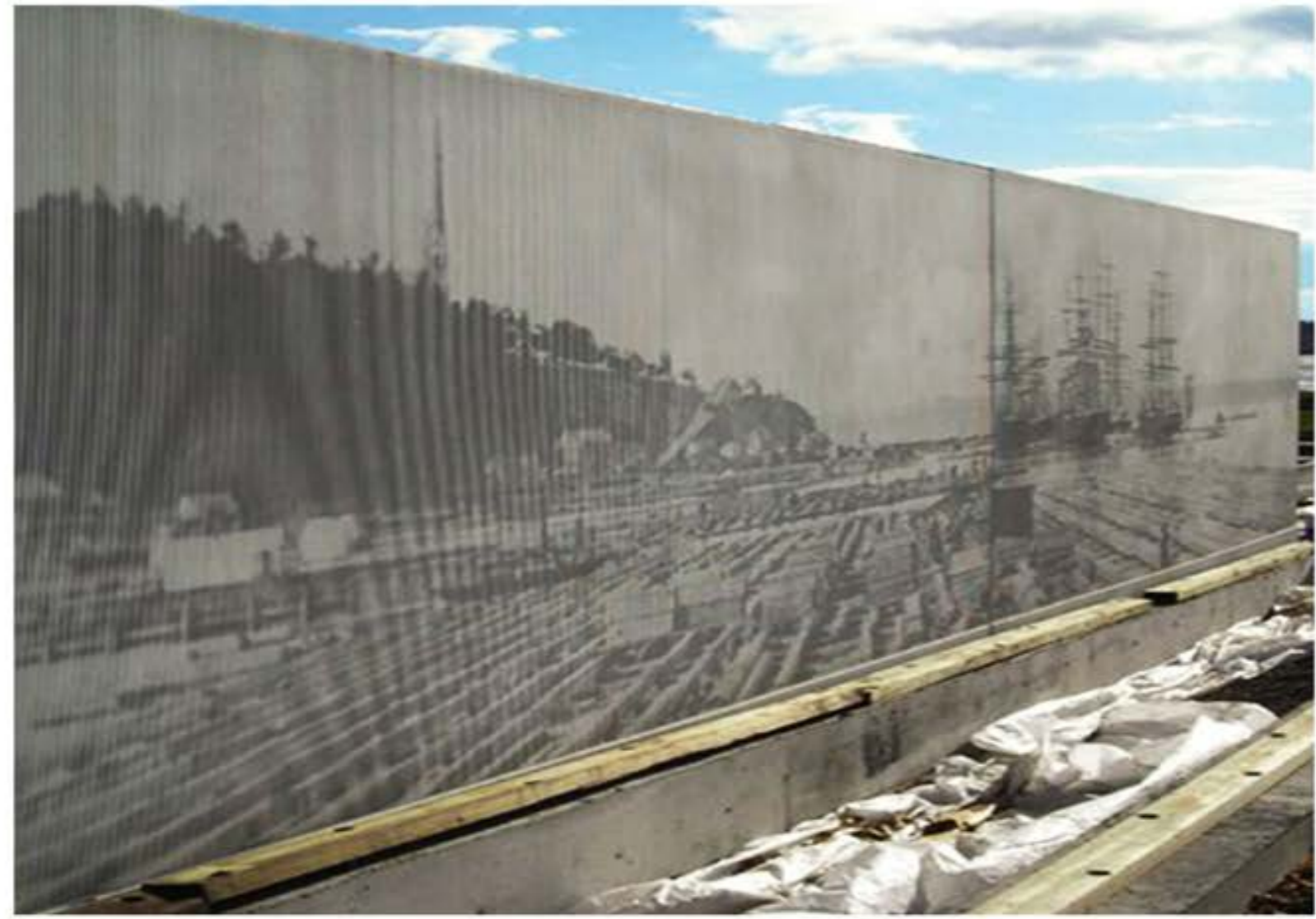
LE QUINTE ARCHITETTONICHE La tecnologia di foto-incisione su matrici in cemento tecnico, consentono una lavorazione della superficie simile alla rappresentazione fotografica
