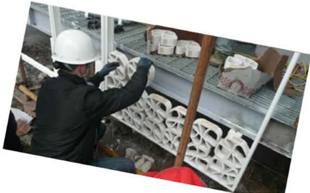
LA CORONA DI CORALLO Le facciate del Padiglione S, nella parte superiore, sono costituite da una nuova "pelle" con funzione schermante e struttura realizzata con elementi in lamiera metallica tagliati a laser e blocchetti in cotto smaltato.
